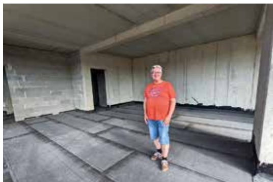
Im Untergeschoss entstehen die Räume für die CVJM-Kinder- und Jugendgruppen
